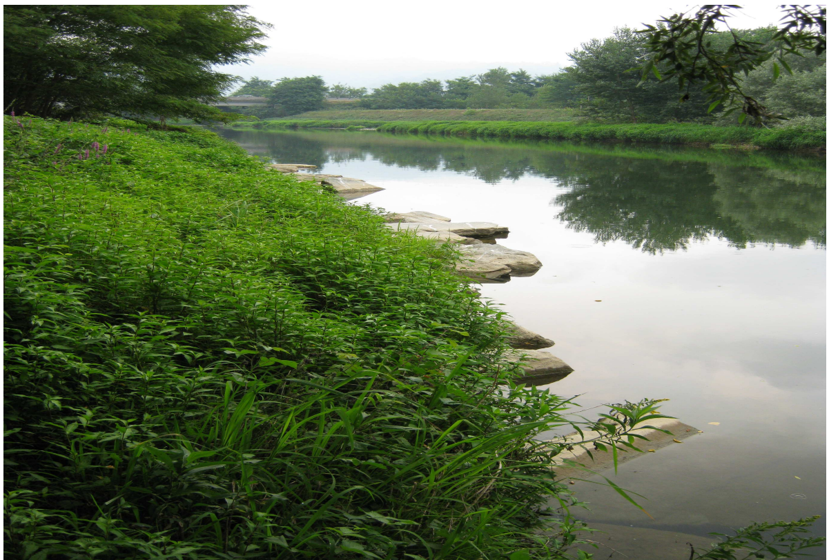
Figura 8– Tratto a valle della S.P. 220 vista verso valle: in sponda sinistra sono visibili i massi scalzati della scogliera in corrispondenza dello stabilimento ESSO.
